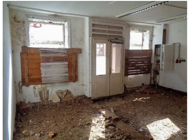
Breite Straße 63 ehemaliger Ladenraum EG
