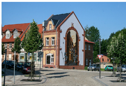
Lieshaus am ehemaligen Seehäuser Tor in der Breiten Straße
