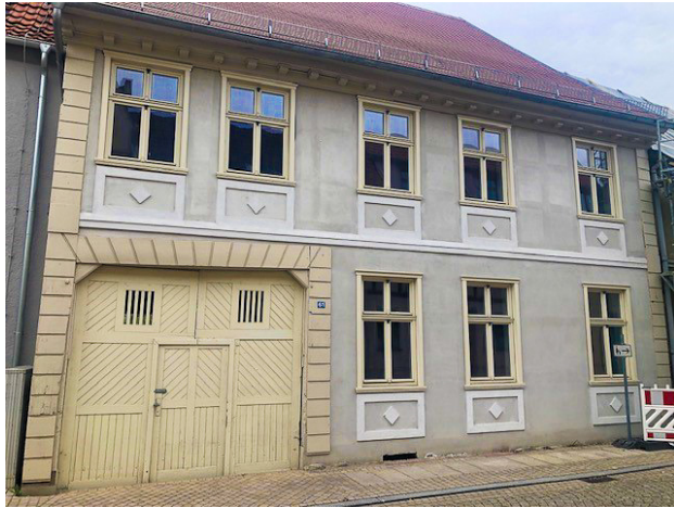
Breite Straße 61 Straßenfassade (neu)
