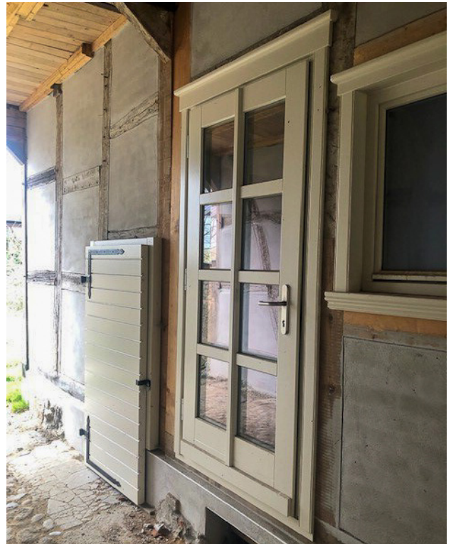
Breite Straße 61 Tordurchfahrt/Eingangs- und Kellertür
